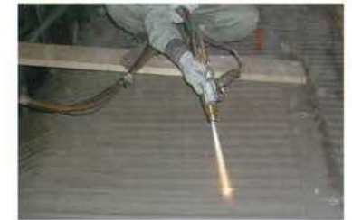
現地溶射施工 On site spraying
