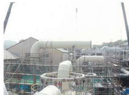
ガス洗浄設備 FRPダクト据付 FRP ducting work
