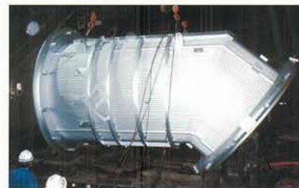
OG上部フード据付工事 Installation work of OG top hood
