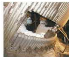
OG上部フード部分更新 OG top hood partial replacement work
