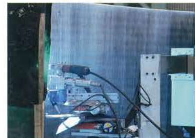
水冷パネルへのインコネル肉盛自動溶接施工状況
