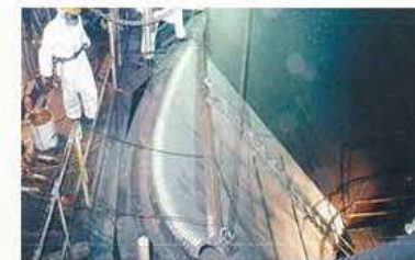
OG上部フード据付状況
