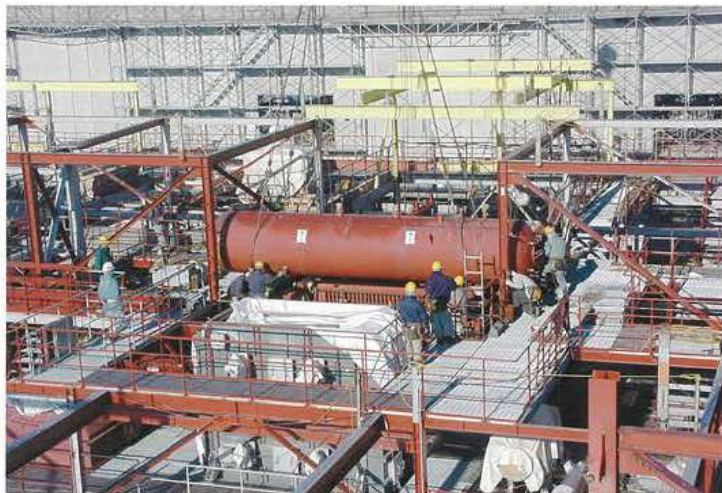
都市ごみ焼却工場 廃熱ボイラー汽水分離ドラム据付 Installation of a steam separation drum for the municipal waste incineration plant
