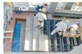
都市ごみ焼却工場ストーカー炉据付工事 Erection work for a stoker-type furnace
