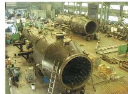
高圧ガス設備 製作状況 Manufacturing a gasification furnace
