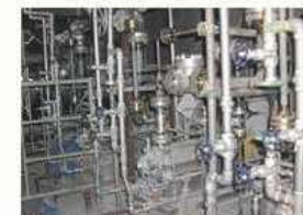
配管・ポンプ据付 Piping work
