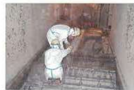
ストーカー炉定修工事 Periodical repair work for a stoker-type incineration furnace
