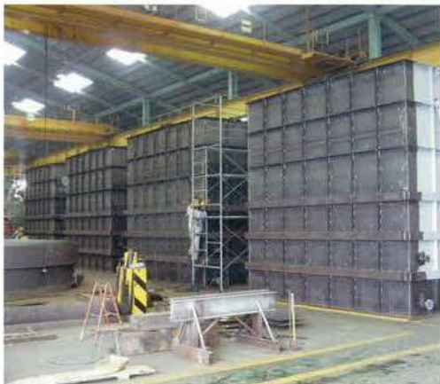
大型原料タンク Large size tanks for raw material
