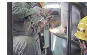
コンベアスクルー軸補修 Repairing the screw conveyor shaft
