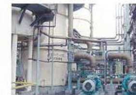
FRP配管・ポンプ据付 Piping work
