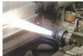
ローラ溶射施工中
