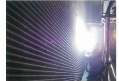
現地溶射施工 On site spraying
