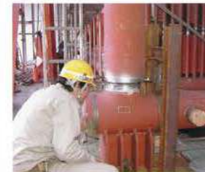
開先確認検査
