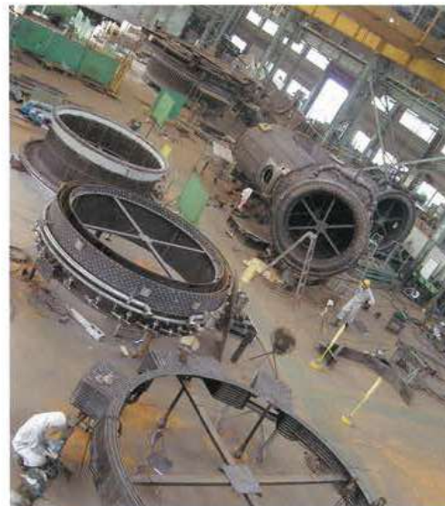
転炉ガス回収装置 OG設備製作状況 Manufacturing oxygen converter gas recovery system
